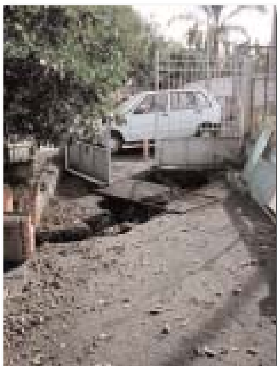
Figura 2.3.6: Fratturazione del manto stradale e nel terreno in località Scura.
