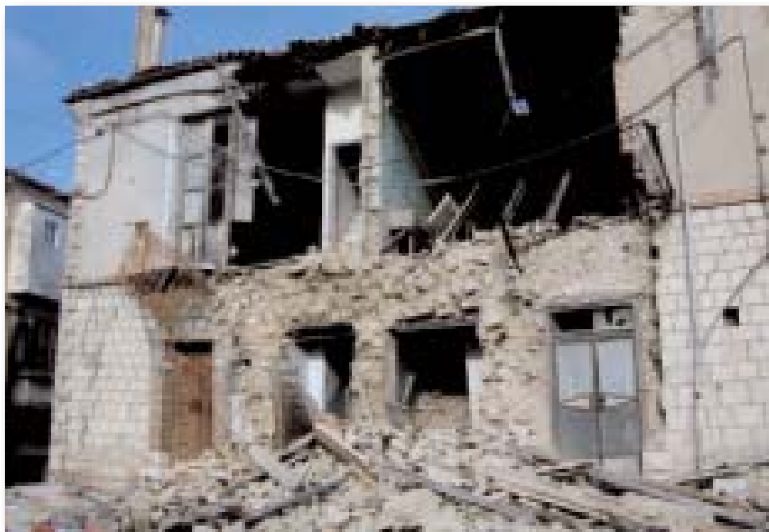
Figura 2.4.11: Casacalenda. Serie di aperture troppo ravvicinate a piano terra che hanno indebolito la struttura in pietra.
