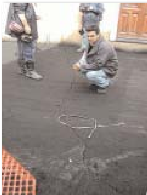
Figura 2.3.5: Fratturazione del manto stradale nel centro abitato di S. Venerina (a destra) e in località Dagala Canne (a sinistra).
