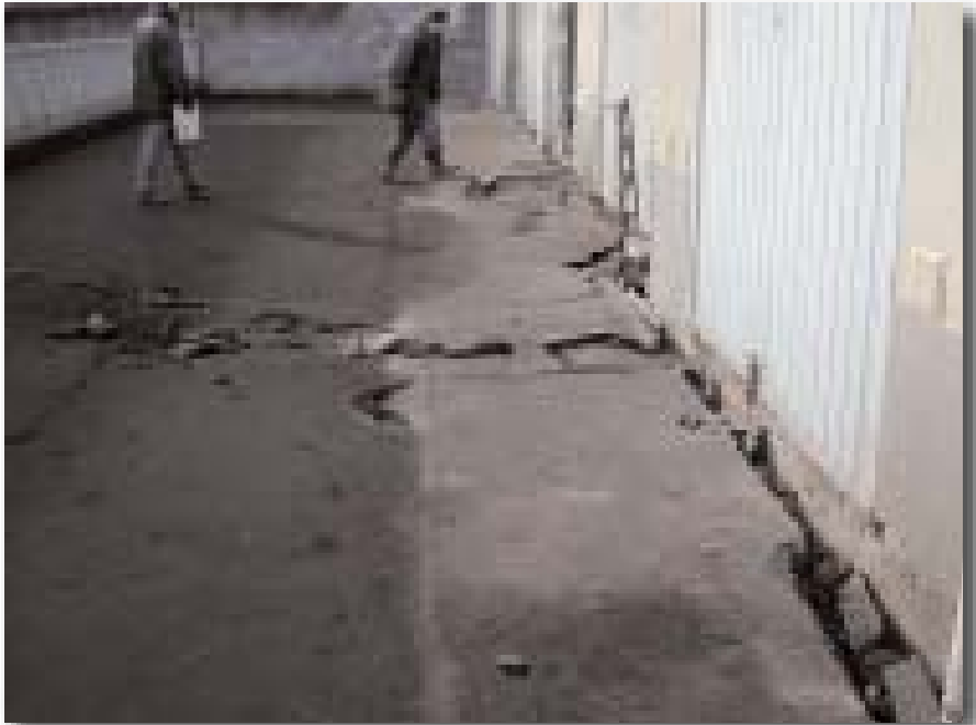
Figura 2.3.19: Dislocazione del suolo e conseguente traslazione di una intera porzione di un fabbricato a S. G. Bosco.
