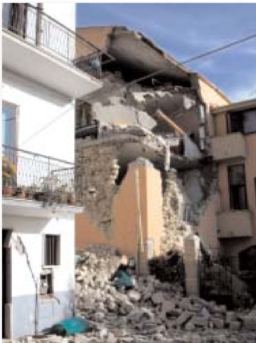
Figura 2.4.19: S. Giuliano di Puglia. Vecchio edificio in muratura di pietra ristrutturato con inserimento di solai in c.a. rigidi.
