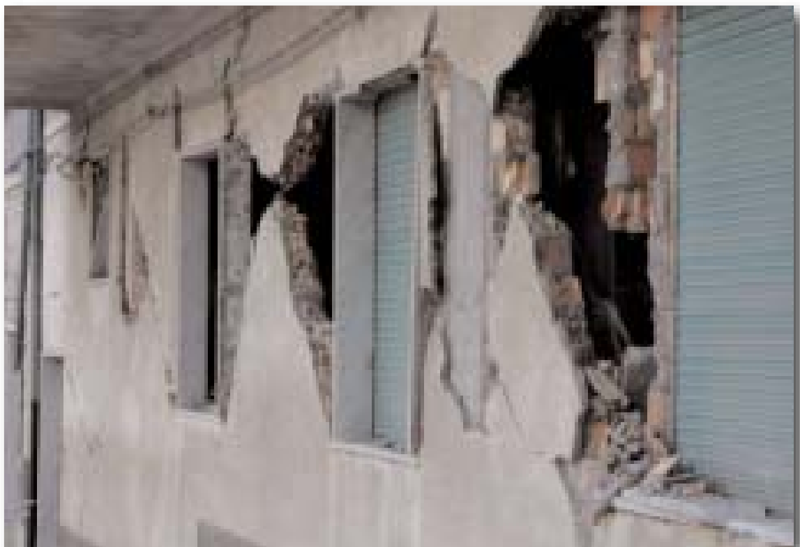
Figura 2.4.16: S. Giuliano di Puglia. Fessurazioni incrociate lungo Corso V. Emanuele.
