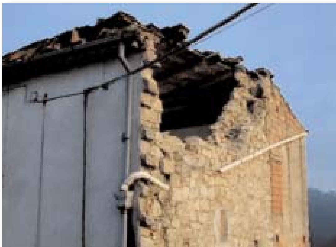
Figura 2.4.12: Bonefro. Crollo provocato dalla spinta del tetto e dalla mancanza del cordolo di coronamento.
