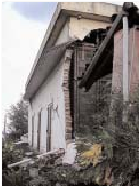
Figura 2.3.13: Struttura portante verticale realizzata con un unico corso di mattoni (S. Venerina).
