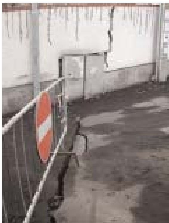
Figura 2.3.5: Fratturazione del manto stradale nel centro abitato di S. Venerina (a destra) e in località Dagala Canne (a sinistra).
