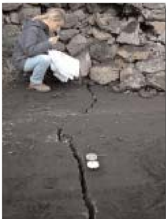
Figura 2.3.5: Fratturazione del manto stradale nel centro abitato di S. Venerina (a destra) e in località Dagala Canne (a sinistra).
