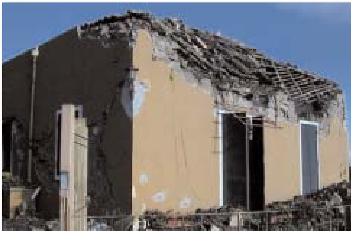
Figura 2.3.14: Crollo del tetto in un vecchio edificio in muratura di pietrame (S. G. Bosco); può essere osservata la mancanza del cordolo e la sostanziale tenuta delle catene.
