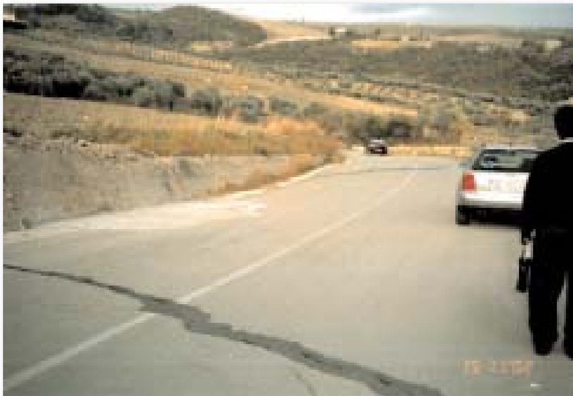
Figura 2.4.9: Corona di frana che interessa la sede stradale a sudest dell'abitato di San Giuliano di Puglia. Il movimento è risultato ancora in atto due settimane dopo il sisma.
