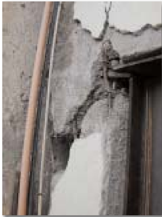
Figura 2.3.18: Pilastro lesionato da sollecitazione di taglio (S. G. Bosco).
