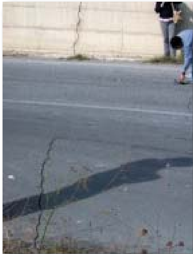
Figura 2.4.6: Frattura sulla strada Colletorto-San Giuliano, che interessa sia il manto stradale che il muro di contenimento in c.a.
