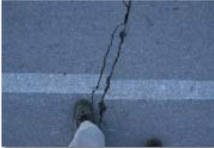
Figura 2.4.5: - Dislocazione visibile su una frattura ricollegabile ad un movimento franoso a sud dell'abitato di San Giuliano di Puglia.
